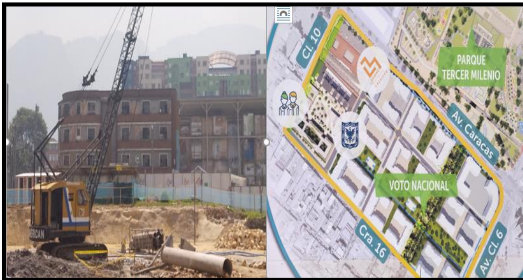
Imagen No. 3 Convenio 299-2019 -Situación de obra Edificio SENA
